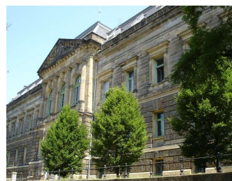
Dienstgebäude BAuA Dresden
